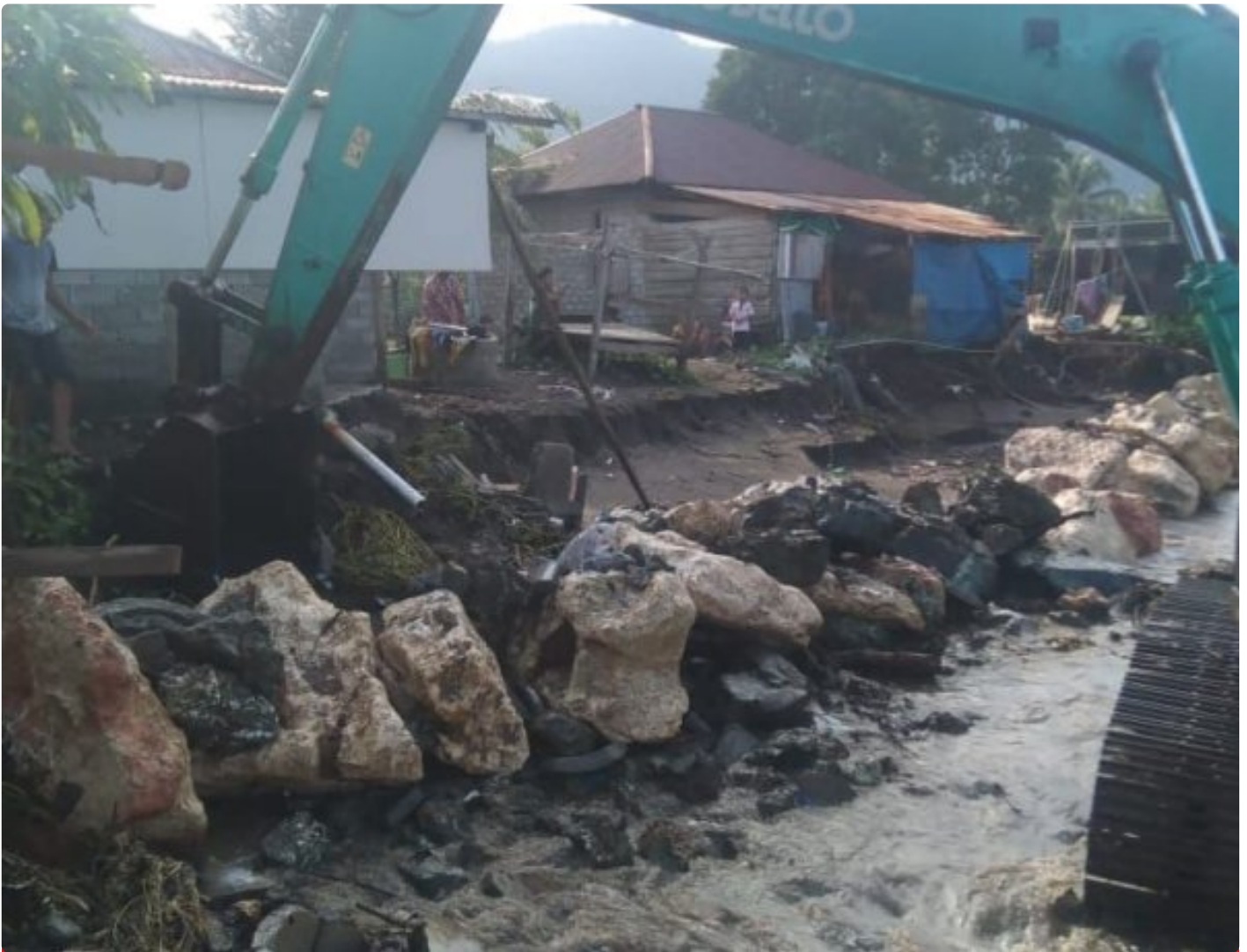
Proyek pemecah ombak di desa kolono
